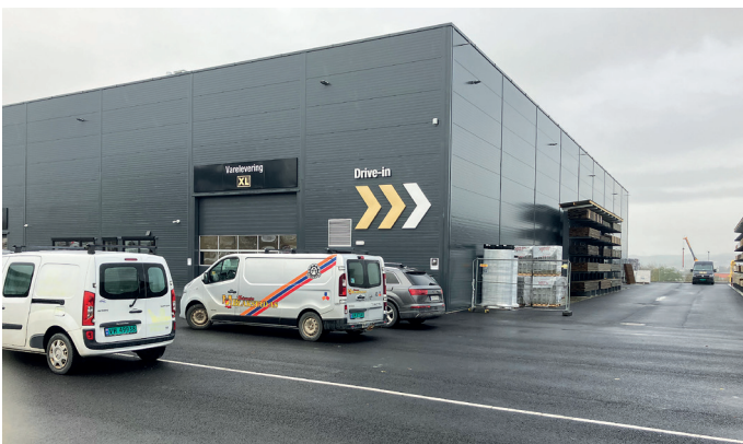
Innkjøringen direkte til varehuset for de som skal hente større varer.
